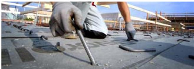
2. Particolare di inserimento del connettore a taglio nel foro riempito di resina.
