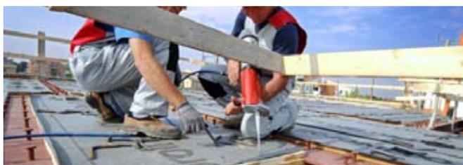
3. Particolare di inserimento del connettore a taglio nel foro riempito di resina.
