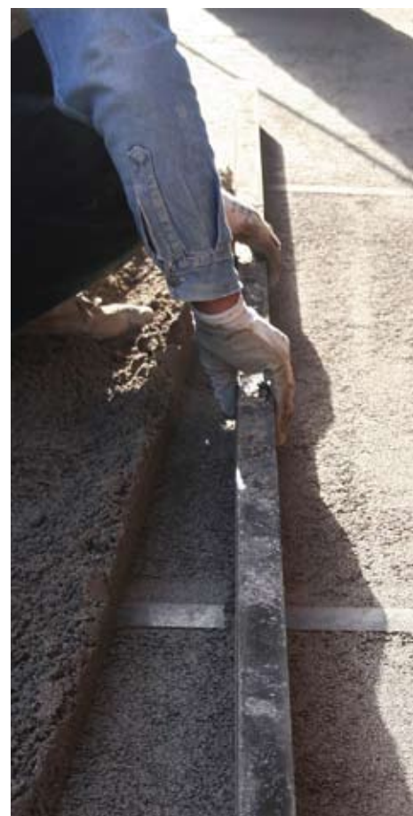
Giunto con incisione a fresco o taglio meccanico
